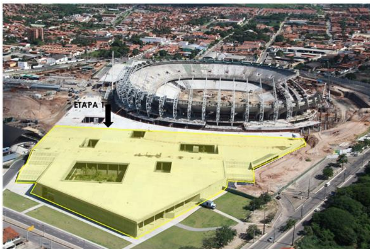
Edifício Sede SESPORTE e Estacionamento Coberto 1 (Ago/2011)
