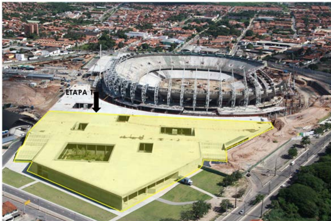
Edifício Sede SESPORTE e Estacionamento Coberto 1 (Ago/2011)
