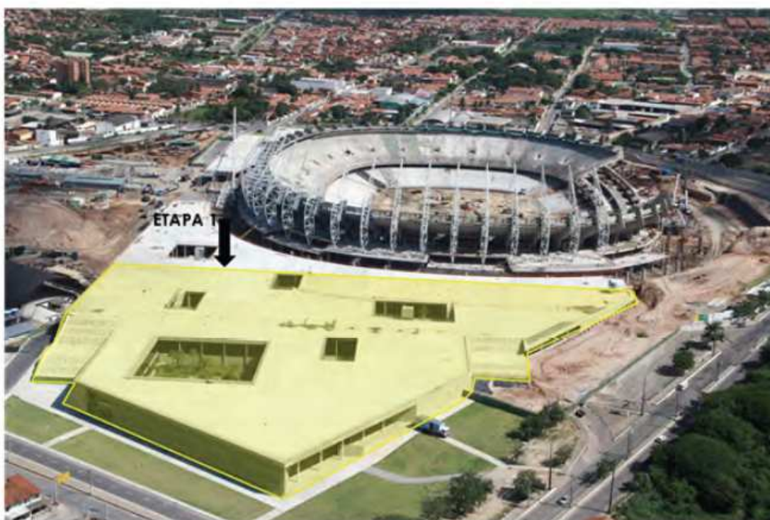
Edifício Sede SESPORTE e Estacionamento Coberto 1 (Ago/2011)
