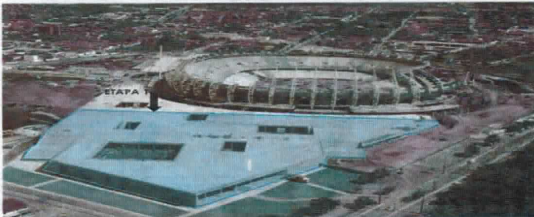
Edifício Sede SESPORTE e Estacionamento Coberto 1 (Ago/2011)
