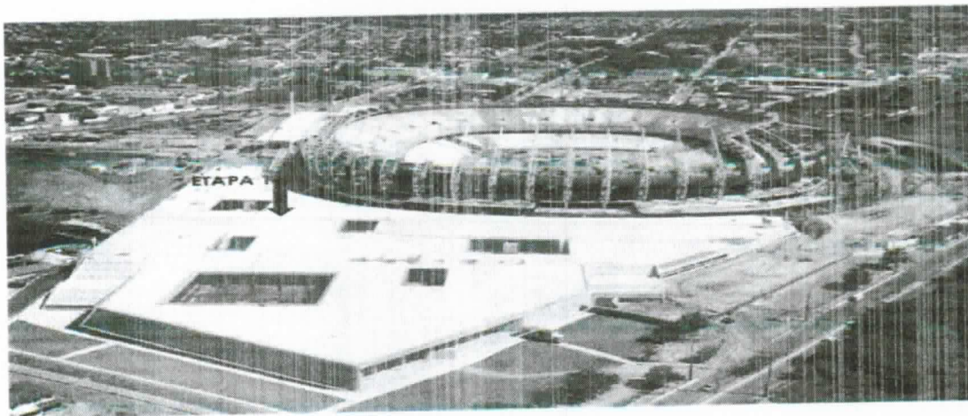
Edifício Sede SESPORTE e Estacionamento Coberto 1 (Ago/2011)
