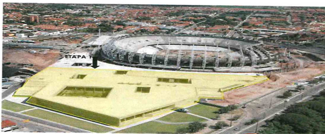
Edifício Sede SESPORTE e Estacionamento Coberto 1 (Ago/2011)
