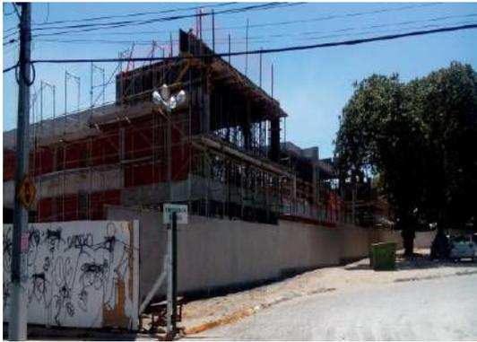
Execução de alvenarias fechamento e escoras/ formas para laje de cobertura sobre a laje técnica.
