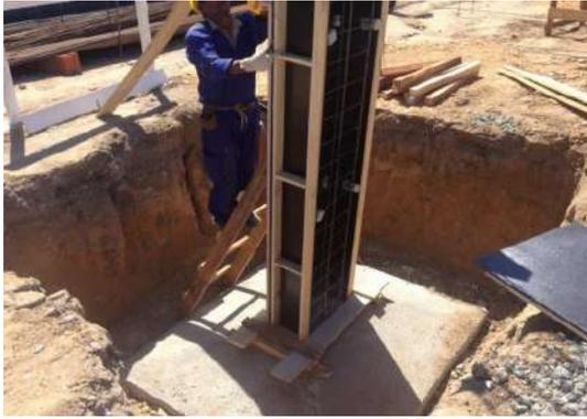
Início de Montagem de formas para concretagem dos pilares (superestrutura).
