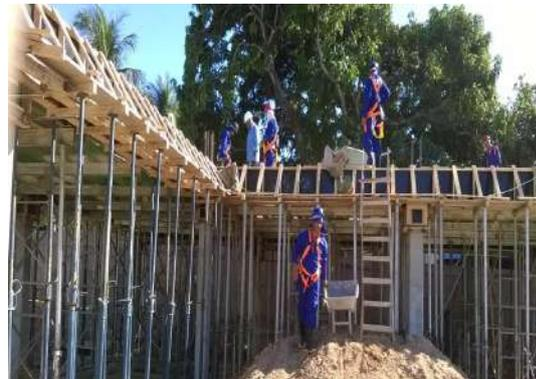
Montagem de Escoras para Concretagem da laje técnica superior (superestrutura).
