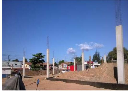
Conclusão da concretagem de pilares para 1º nível de vigas (superestrutura).
