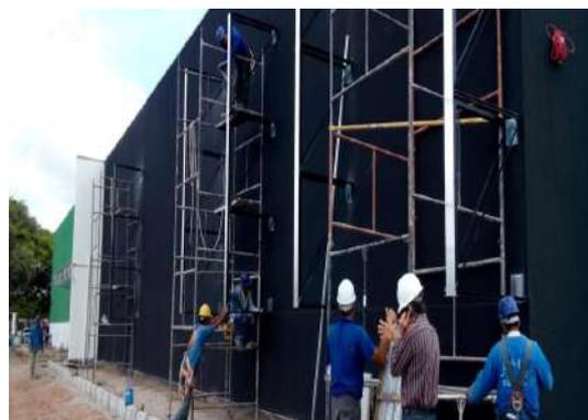
Serviços de Pintura de Fachada e Montagem de estrutura metálica para placas de Proteção
