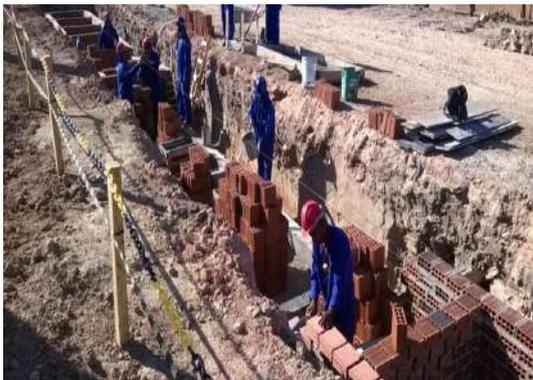
Execução dos sumidouros para águas pluviais e água tratada na ETE.
