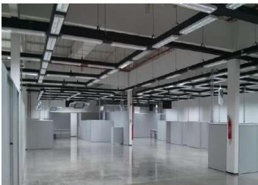
Finalização dos serviços de piso industrial, instalações, pintura, montagem de divisórias e limpeza.
