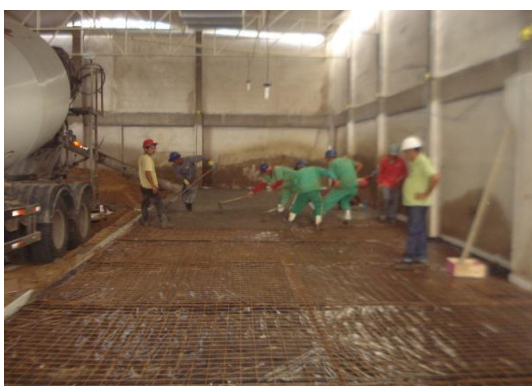
Execução da laje de piso em concreto polido.
