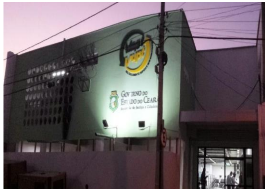
Fachada Lateral da unidade de atendimento finalizada
