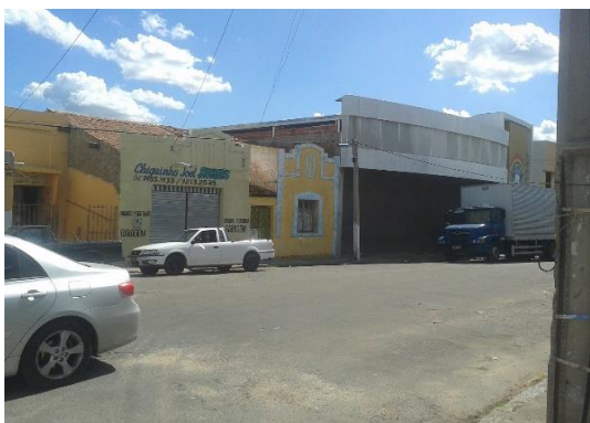
Vista frontal do Galpão Existente (Rua Cel. José Silvestre 201).
