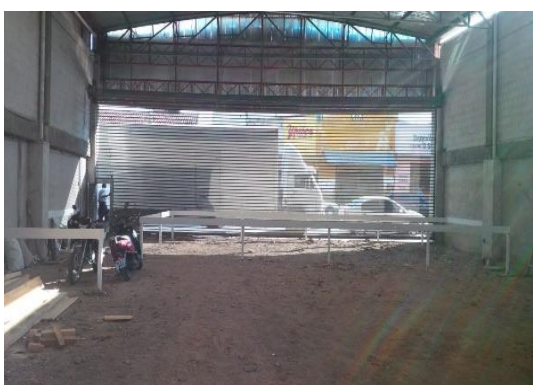
Início do serviço montagem de Gabaritos para locação das fundações.
