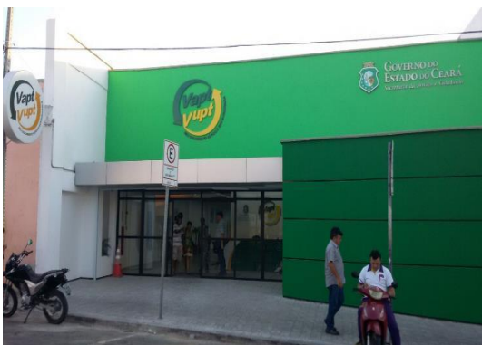
Fachada Principal da unidade de atendimento finalizada.
