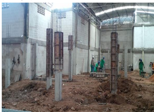
Conclusão da concretagem de pilares para 1º nível de vigas (superestrutura).
