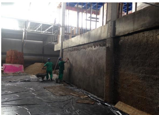
Execução de Reboco c/impermeabilizante nas Alvenarias Periféricas.
