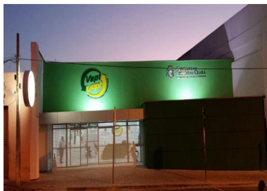
Fachada Principal da unidade de atendimento finalizada.
