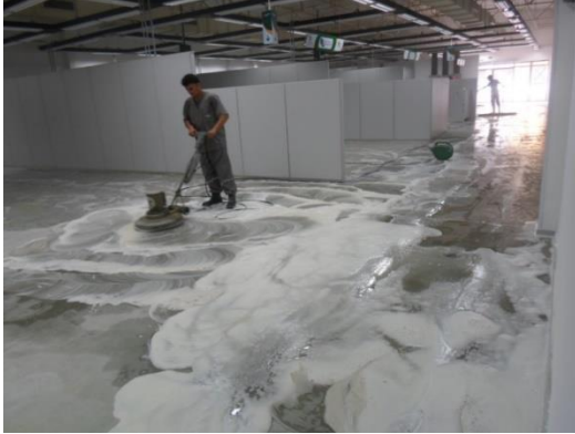
Finalização dos serviços de piso em concreto polido e limpeza.
