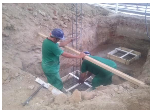
Início de Concretagem das primeiras sapatas (fundação).
