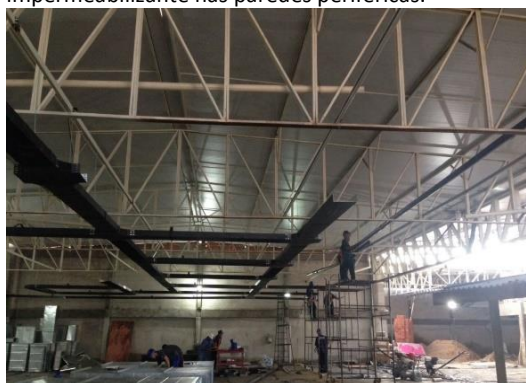
Execução dos serviços de Colocação das Eletrocalhas Elétricas e Dados sobre a Coberta Nova.
