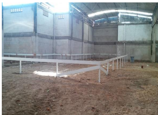
Início do serviço montagem de Gabaritos para locação das fundações.
