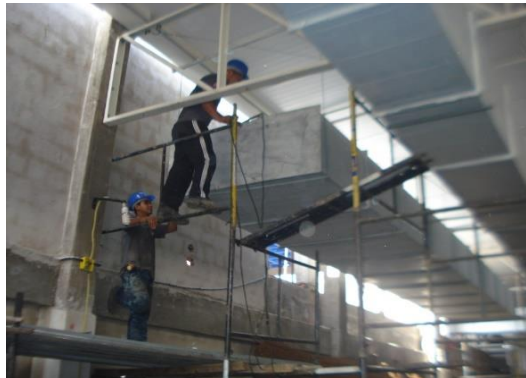
Execução dos serviços de Colocação dos Dutos do Sistema de Climatização sobre a Coberta Nova.
