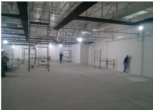
Execução de Reboco c/impermeabilizante nas Alvenarias Periféricas.
