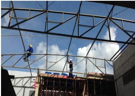
Retirada da Coberta Metálica Existente.
