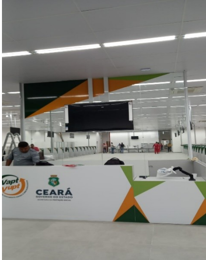
Instalação de Comunicação Visual
