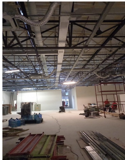
Instalação de Ar Condicionado
