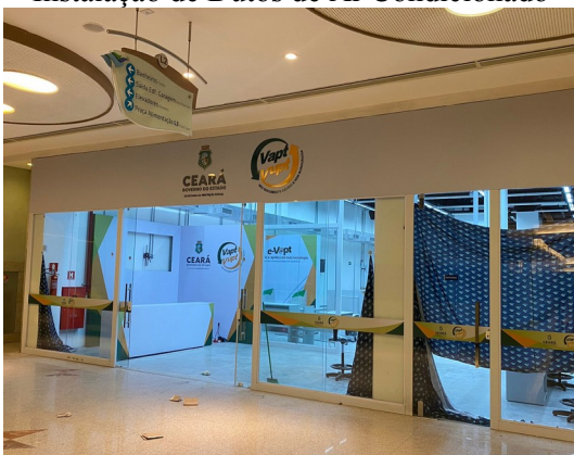
Instalação de Comunicação Visual
