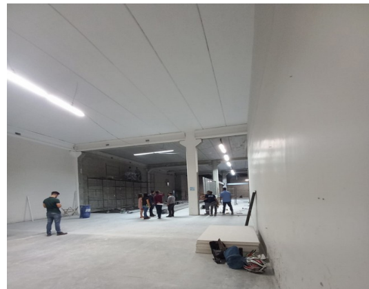
Início das Obras
