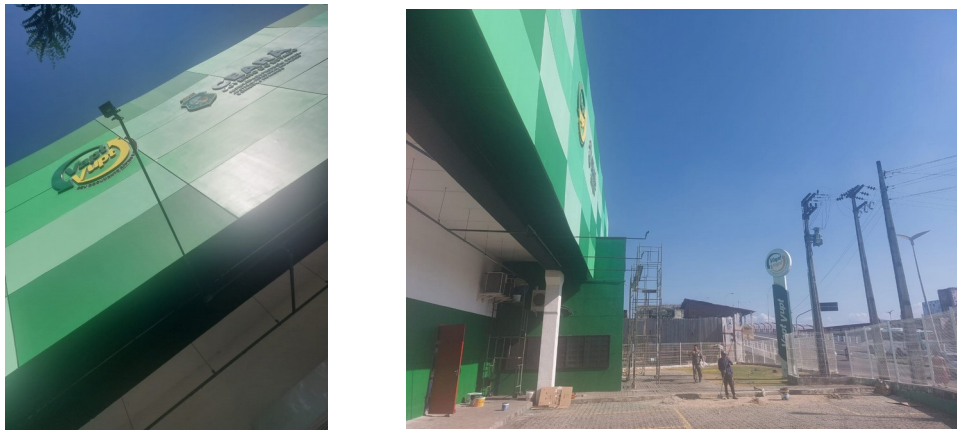
Figura 101: Verificação de NCE
