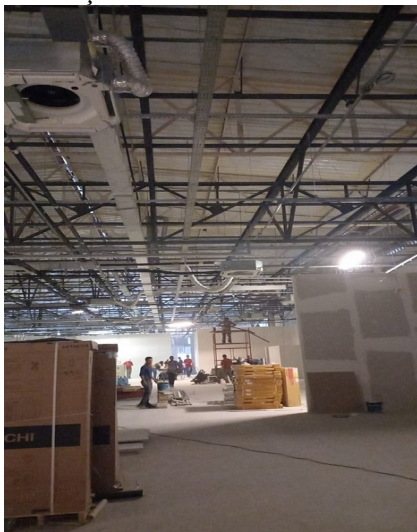
Instalação de Ar Condicionado
