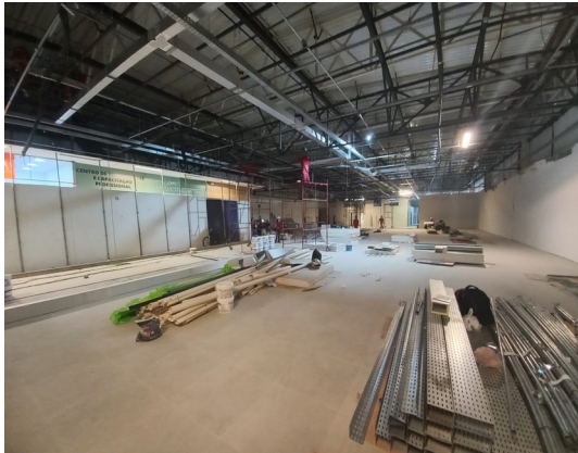
Instalações de Piso e Eletrocalhas
