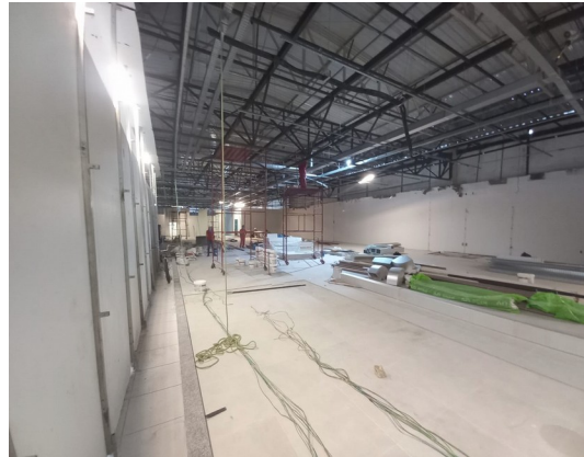
Instalações de Piso e Eletrocalhas
